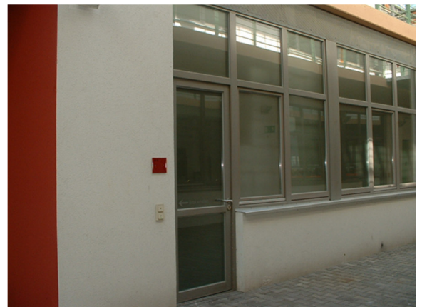
Halle A5 – Eingang in Passage
