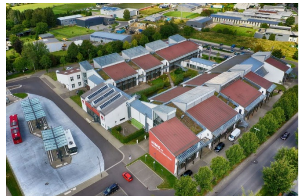
Luftaufnahme HIMO mit Bushof
